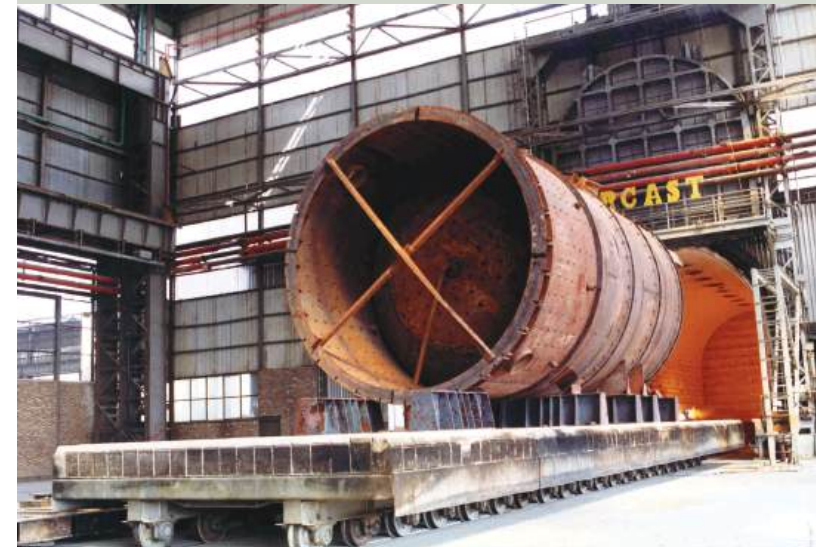
▲ کوره های عملیات حرارتی
