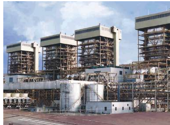
▲ بویلرهای نیروگاه شهید رجایی
